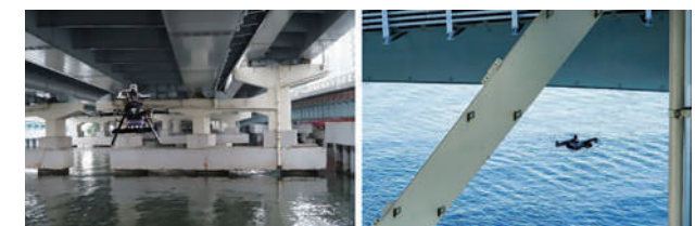
橋梁の定期点検前スクリーニングを行う大型ドローンの飛行の様子
