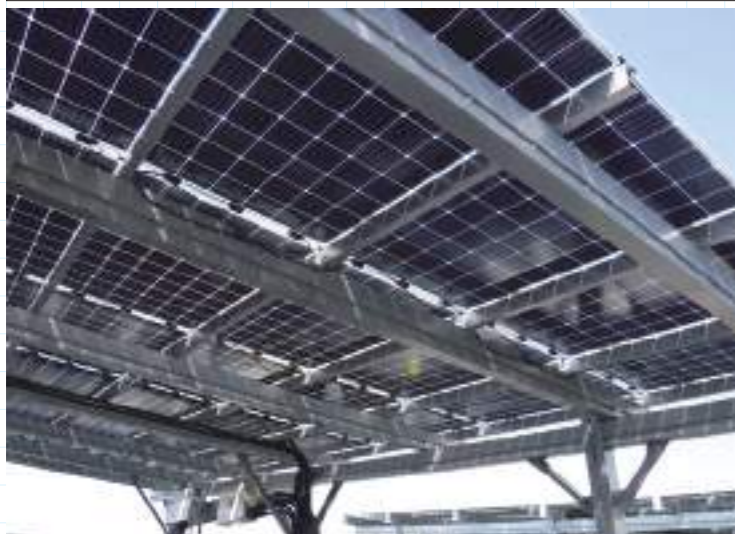
(写真2)裏面にも発電機能を作り込んだ太陽電池の例
