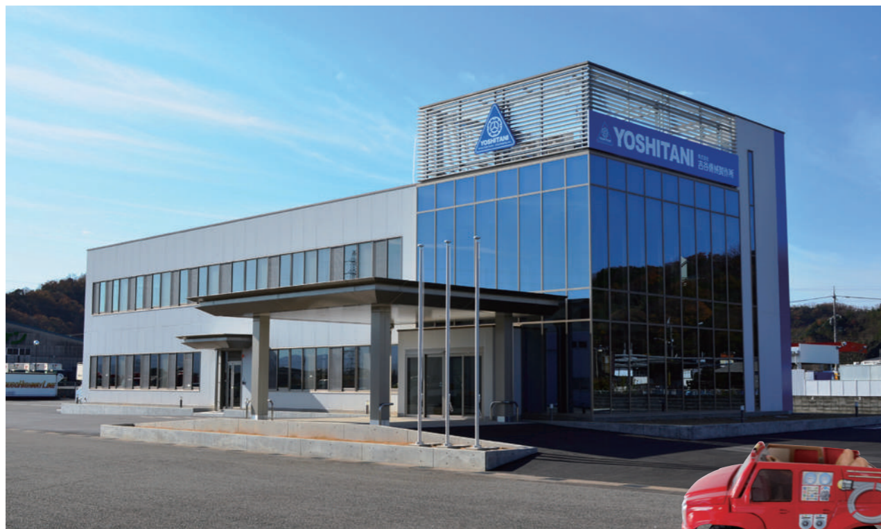
吉谷機械製作所のモダンな新しい事務棟
