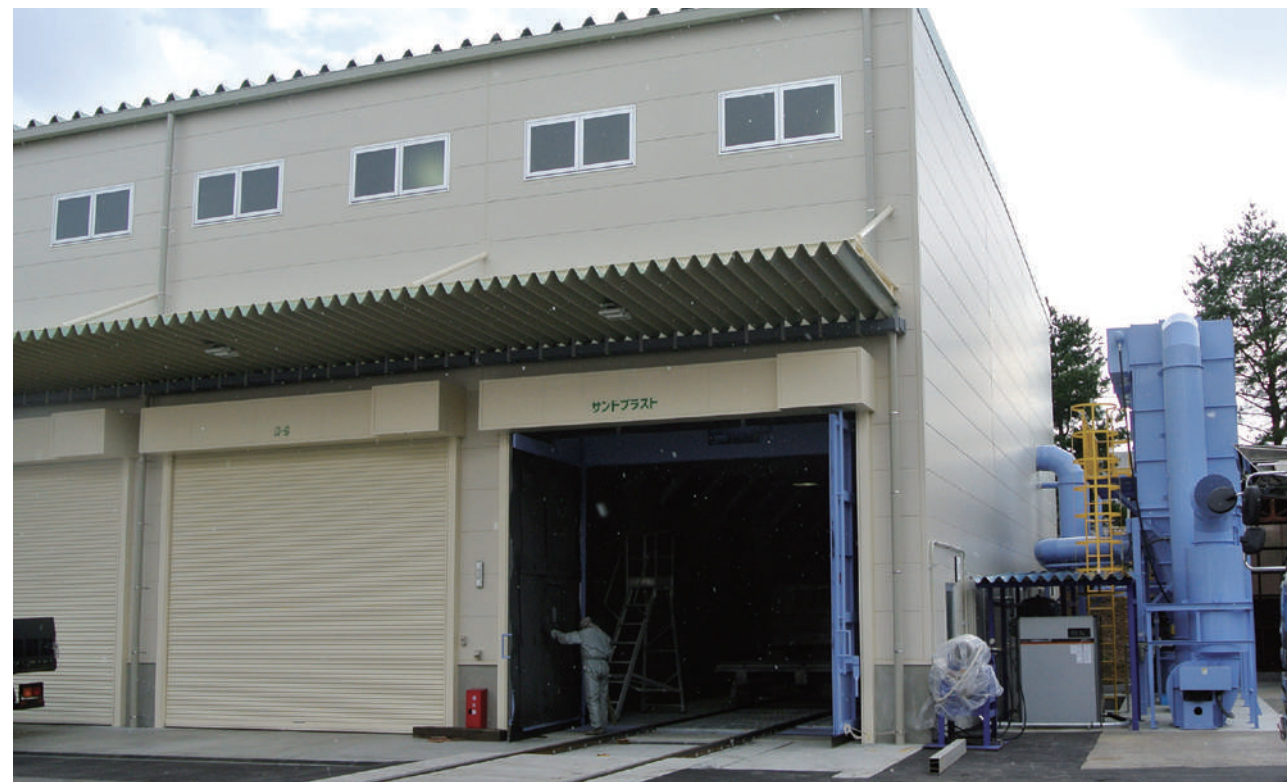
本社敷地内に完成した新工場。側面にショットブラスト回収装置が見える。
