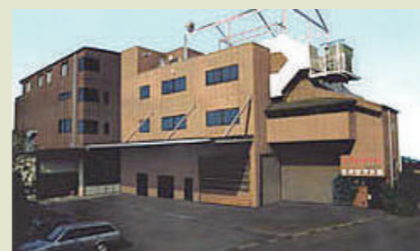
本社工場事務所
