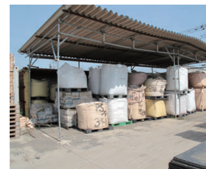
廃プラ材料乾燥施設
