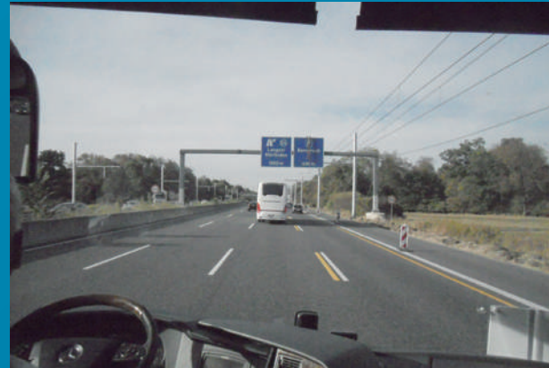
ドイツ国内アウトバーンで建設中の給電用架線(例)
