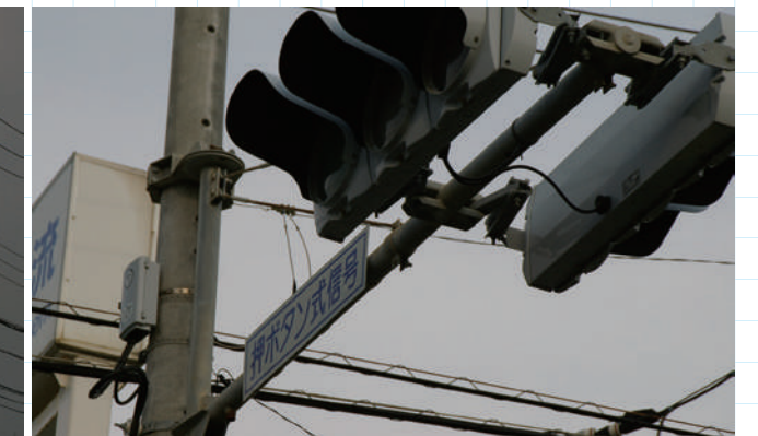
輸送準備作業は通過貨物と干渉の恐れのある道路施設に及ぶ。通常通行車両に正対する信号機はその対象の一つ。一般の場合とは異なり、回転式のブラケットを介して電柱に取り付けられている。軸部のピンを抜き90度回転させて信号機は車両の進行方向と並行になり超大貨物の干渉を回避する。この作業は道路が閉鎖されてから実際に貨物が通過する迄の短時間に行われる
