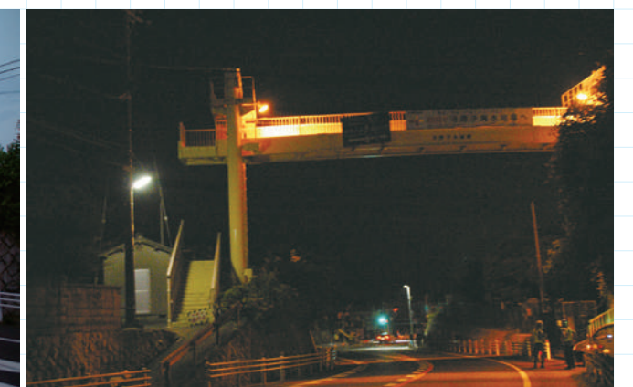
横断歩道橋も関係施設だ。一見して普通の歩道橋と違って無いが、左右の支柱が円柱でかなりの高さがある。上部に電動巻き上げ式のウィンチが搭載されており、これで通常より4mほど上部に巻き上げられる。この写真の歩道橋はウィキペディアに「昇開式歩道橋」の事例として掲載されている
