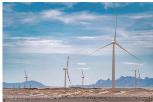
エジプトのガルフ・エル・ゼイト地区に豊田通商が建設した風力発電所(参考写真)
