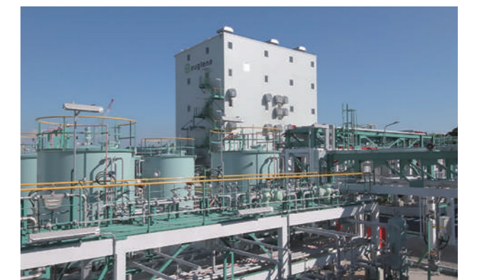
2018年秋に横浜市鶴見区に建設されたユーグレナのバイオジェット・ディーゼル燃料製造実証プラント
