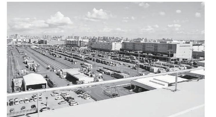
屋上駐車場から見た構内のコンテナヤード
