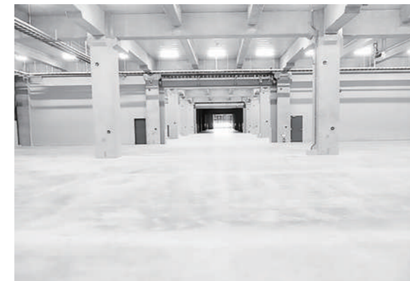
梁下有効高5.5メートルと余裕の空間
