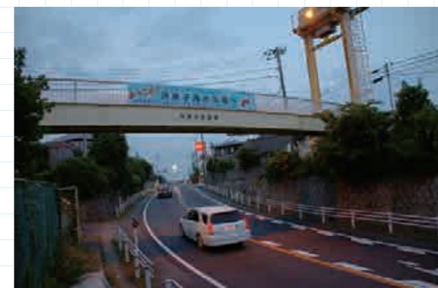
横断歩道橋も関係施設だ。一見して普通の歩道橋と違って違いは無いが、左右の支柱が円柱でかなりの高さがある。上部に電動巻き上げ式のウィンチが搭載されており、これで通常より4mほど上部に巻き上げられる。この写真の歩道橋はウィキペディアに「昇開式歩道橋」の事例として掲載されている
