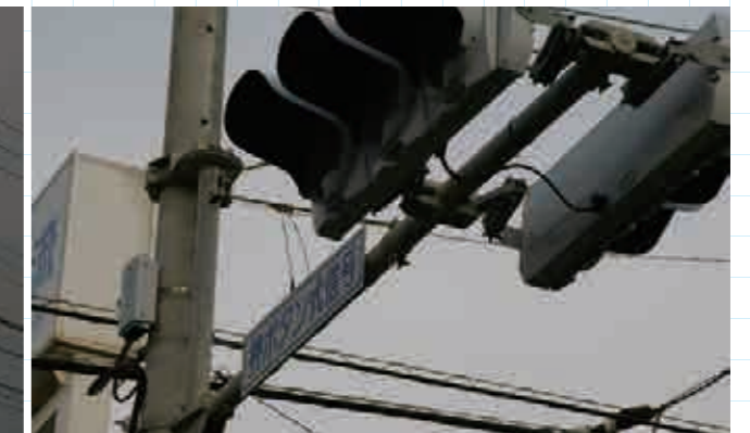
輸送準備作業は通過貨物と干渉の恐れのある道路施設に及ぶ。通常通行車両に正対する信号機はその対象の一つ。一般の場合とは異なり、回転式のブラケットを介して電柱に取り付けられている。軸部のピンを抜き90度回転させて信号機は車両の進行方向と並行になり超大貨物との干渉を回避する。この作業は道路が閉鎖してから実際に貨物が通過する迄の短時間に行われる
