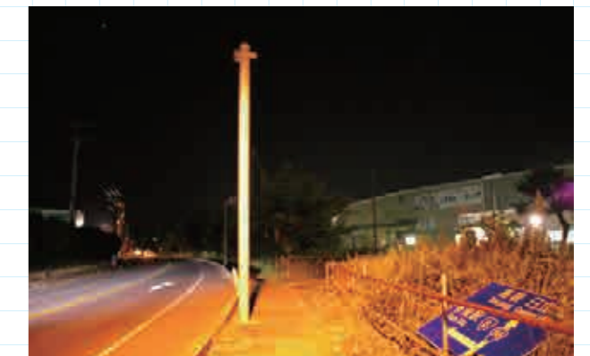
一時的に取り外されて地上に降ろされた道路標識
