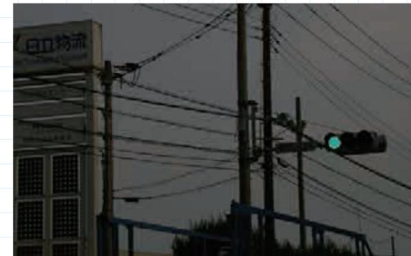
輸送準備作業は通過貨物と干渉の恐れのある道路施設に及ぶ。通常通行車両に正対する信号機はその対象の一つ。一般の場合とは異なり、回転式のブラケットを介して電柱に取り付けられている。軸部のピンを抜き90度回転させて信号機は車両の進行方向と並行になり超大貨物との干渉を回避する。この作業は道路が閉鎖してから実際に貨物が通過する迄の短時間に行われる
