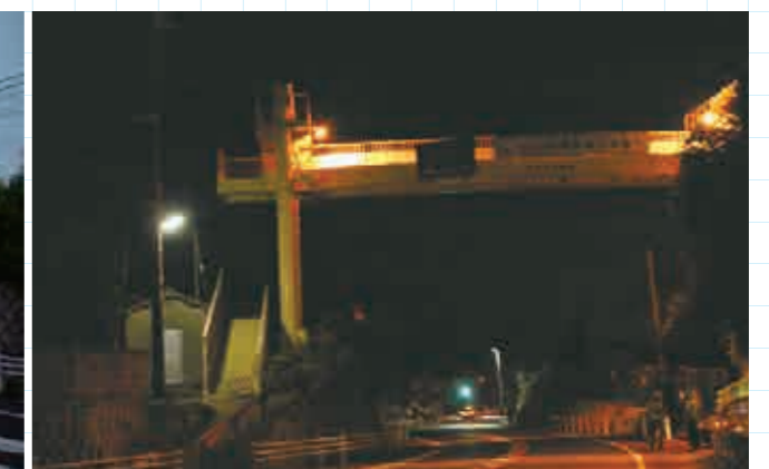
横断歩道橋も関係施設だ。一見して普通の歩道橋と違って違いは無いが、左右の支柱が円柱でかなりの高さがある。上部に電動巻き上げ式のウィンチが搭載されており、これで通常より4mほど上部に巻き上げられる。この写真の歩道橋はウィキペディアに「昇開式歩道橋」の事例として掲載されている
